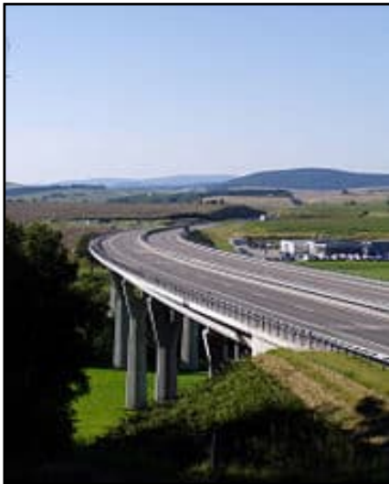
A73 BRÜCKE üB. WERRATAL
